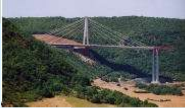
Pile du viaduc de Millau
