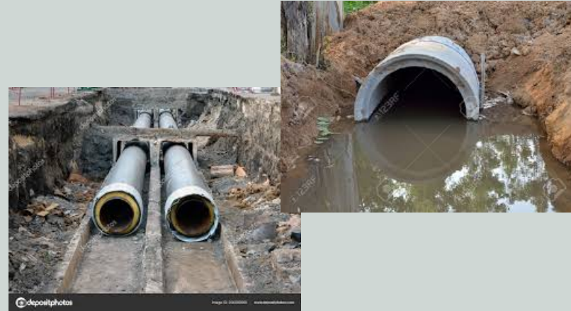
Conduite sous Pression
